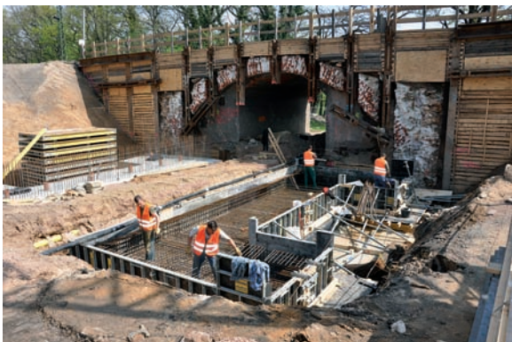
Während auf freier Strecke die Montage der Ausleger für die neue Oberleitung erfolgte (Foto oben), waren die Ingenieurbau-Teams mit der Erneuerung der Eisenbahnüberführungen beschäftigt (Foto unten: Schalungsarbeiten am EÜ Raguhn).
