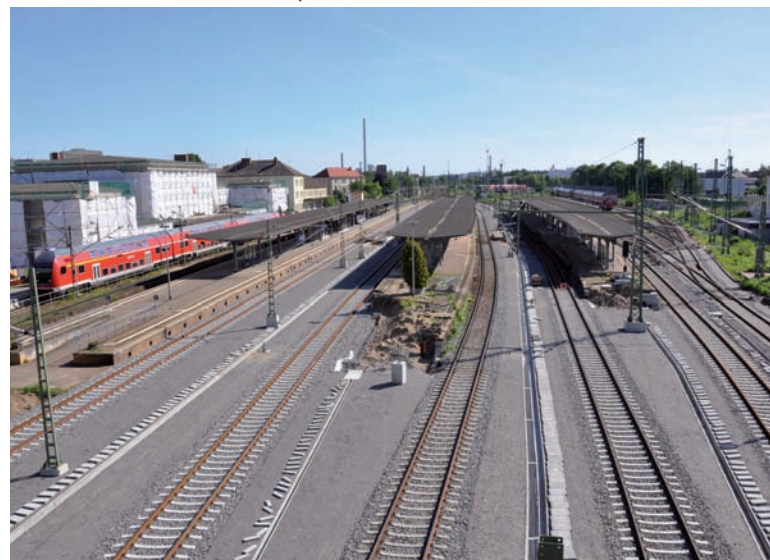
Juni 2010: Die bereits fertig gestellten, neuen Gleisanlagen im westlichen Bereich des Hauptbahnhofes Dessau.
